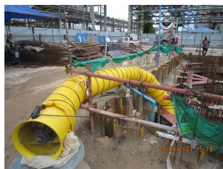
ภาพที่ 2.2-36 เครื่องระบายอากาศ บริเวณพื้นที่อับอากาศ
