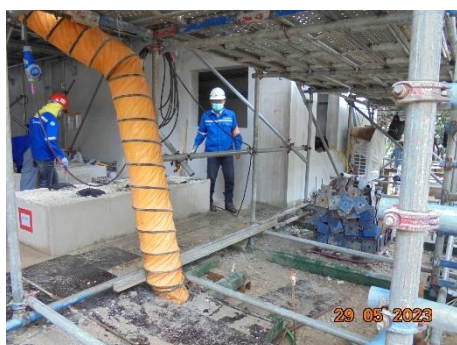
ภาพที่ 2.2-36 เครื่องระบายอากาศ บริเวณพื้นที่อับอากาศ
