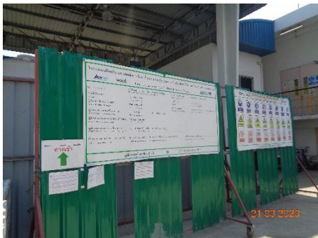
ภาพที่ 2.2-13 รั้วชั่วคราวที่ทำจากแผ่นเหล็กชุบสังกะสี (Metal Sheet)
