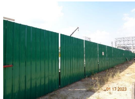
ภาพที่ 2.2-13 รั้วชั่วคราวที่ทำจากแผ่นเหล็กชุบสังกะสี (Metal Sheet)
